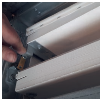
obrázek č. 11 – detail tepelné tavné pojistky u žaluziové klapky a jednotlivé polohy listu při aktivaci
