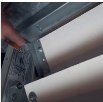
obrázek č. 11 – detail tepelné tavné pojistky u žaluziové klapky a jednotlivé polohy listu při aktivaci
