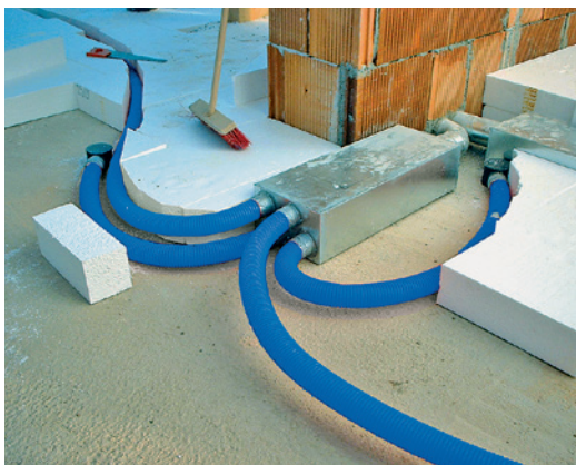
Detail zakázkového rozdělovače EDF-M-BOX a jednotlivých boxů, pro odvodní talířové ventily na půdě budovy, před dokončením a zakrytím izolace
