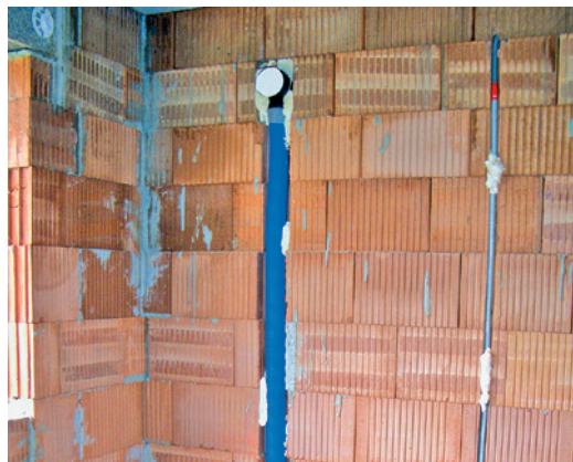
Detail přechodu hadice ED Flex® 75/63 do jámyky pro talířový ventil EDF-SJ-100/75
