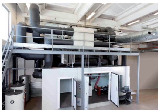
Klimatická komora pro testování rekuperačních jednotek
