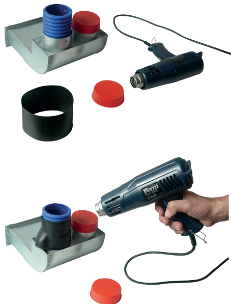
obr. 5 Ukázka montáže s použitím EDF-sealer 75
