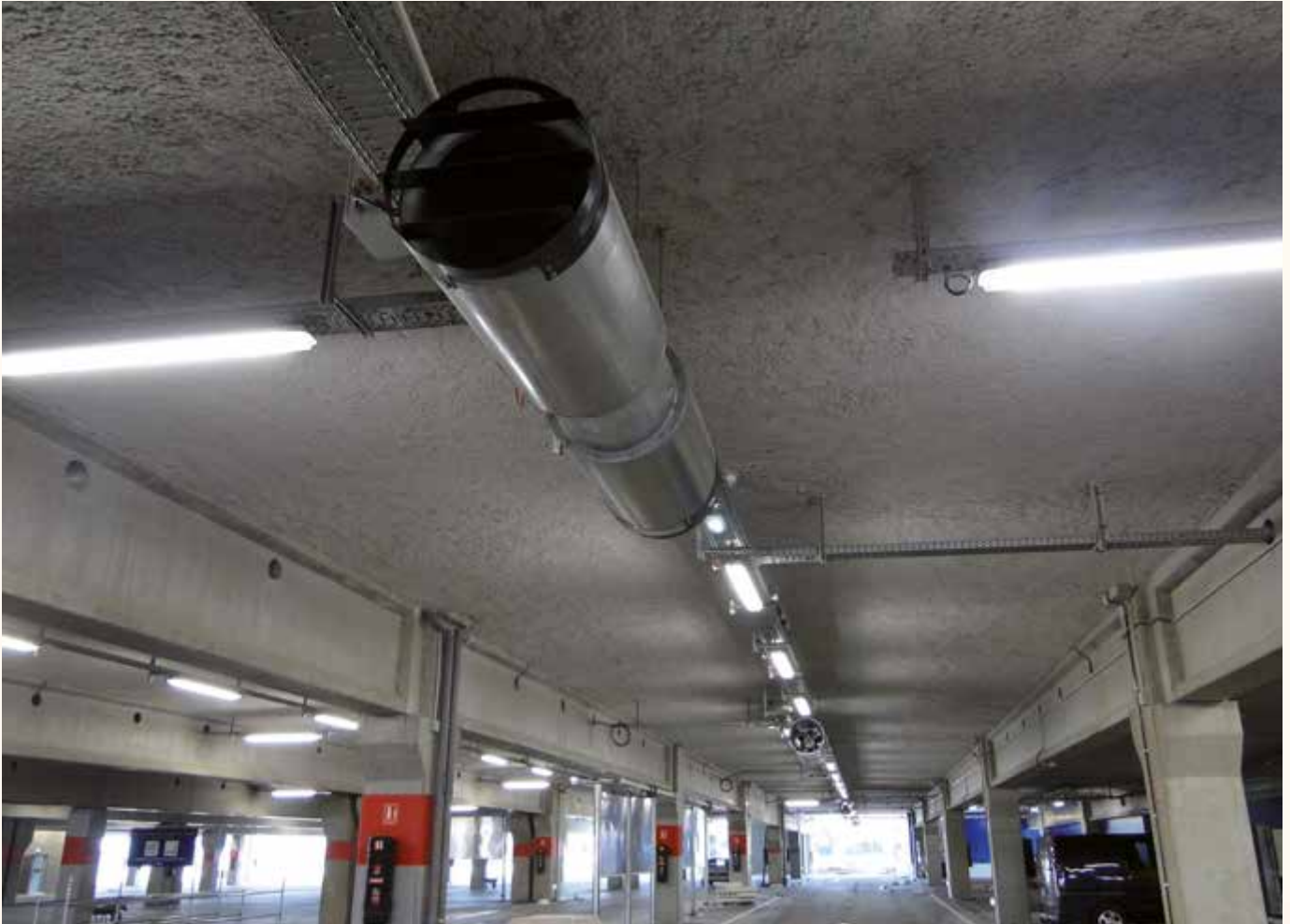
Testování systému v režimu odvodu tepla a kouře.
